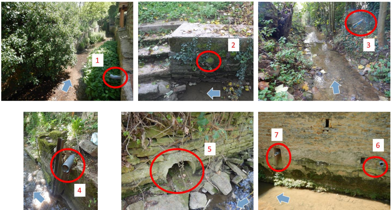
Figure 15 – Reportage photographique des buses en rive droite du ruisseau
