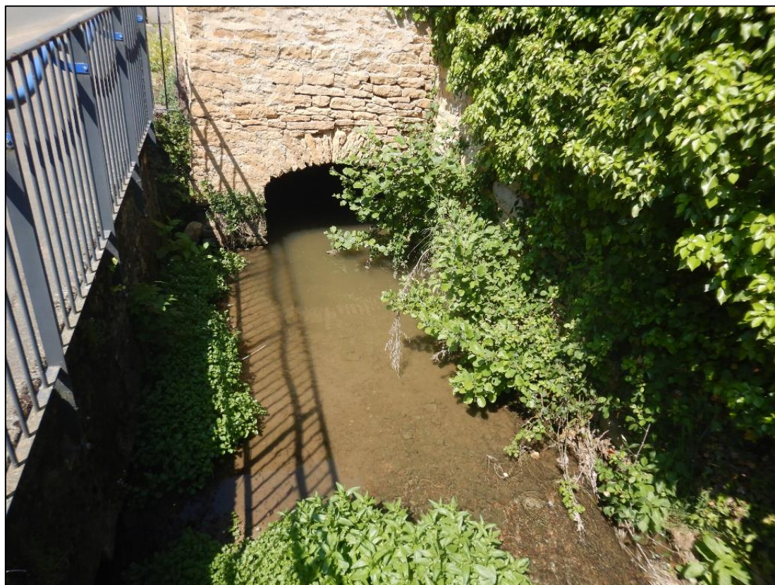
Figure 29 – Ouvrage de la parcelle 273
